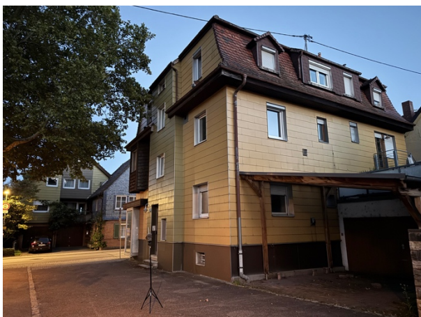
Abb. 7: Position des Batcorders nördlich des Abbruchgebäudes.
